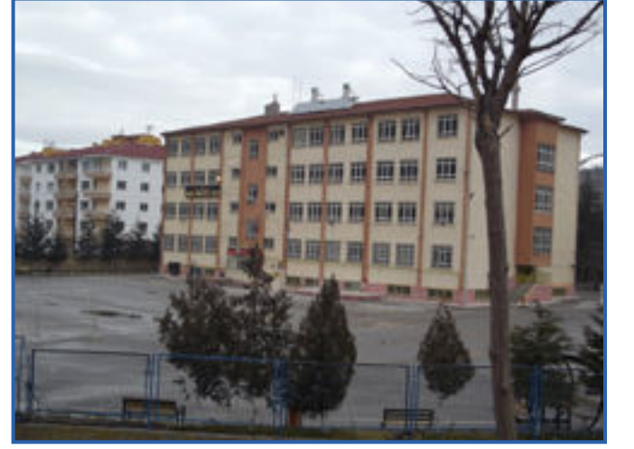
Mamak Köprü Yanındaki Eski Binamız
